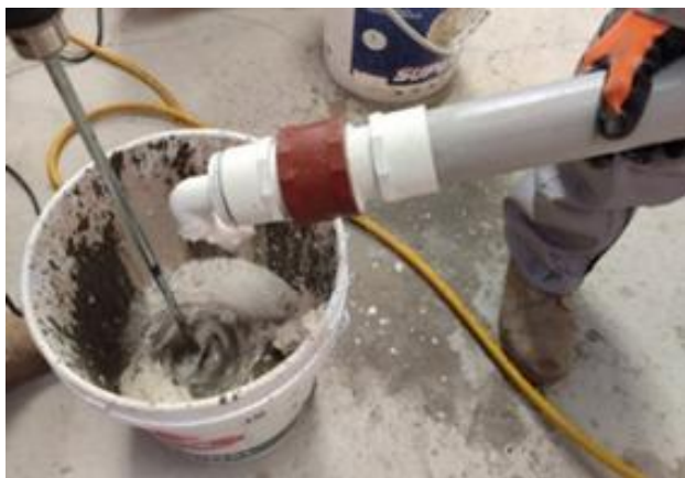
Figura 3. Proceso de mezclado de hormigón celular.
